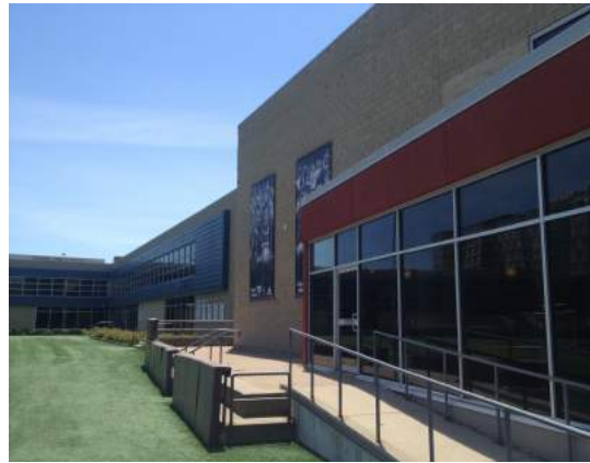
スポーツ施設（グラウンド前）
